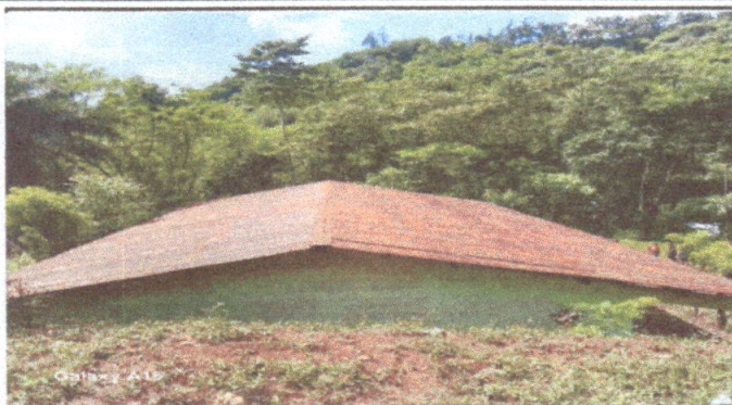
Foto 1: Sustitución de láminas acanaladas por troqueladas
