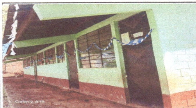
Foto 3: Rehabilitación de entortado en el corredor y aplicación de pintura
