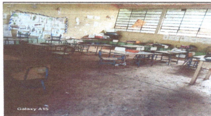
Foto 4: Sustitución de piso de torta por cerámico
