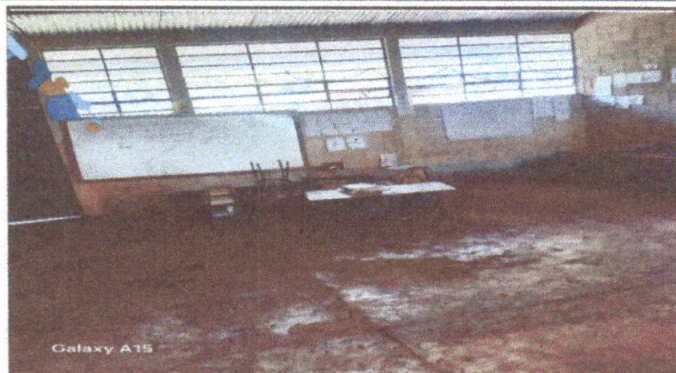
Foto 2: Aplicación de pintura
